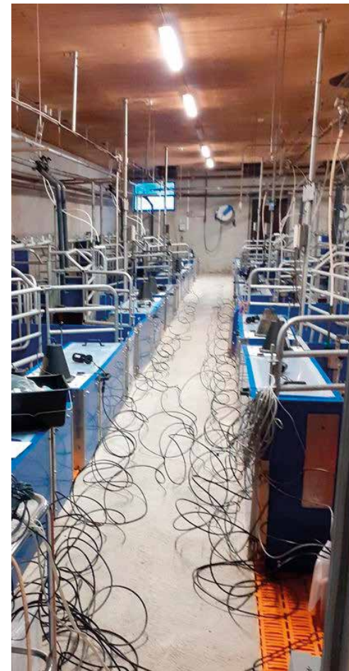
JOKAINEN KAMERA kohdistettiin yksitellen ja koko päivä varattiin kameroiden asennukseen.
