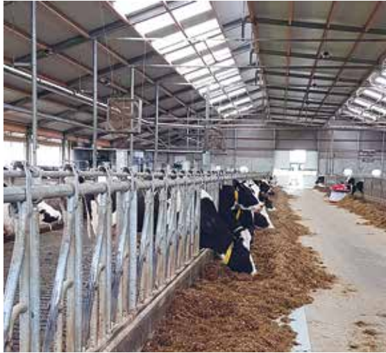
NELJÄN ROBOTIN tilan valoisassa pihatossa rakennuksen harja on kokonaan avoin. Sisäkattona on vino levy, joka kerää sadeveden ja siirtää sen rakennuksen toiseen päähän ränniin.
