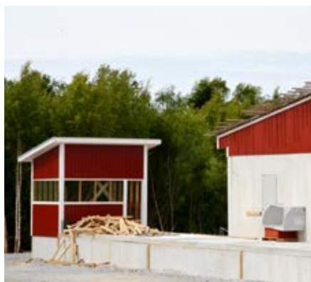
En nyhet vid Jeppo Lantgris. Ett luftintagnings-system. Lantgris anläggning är kvadratmetermässigt störst i hela Finland.
