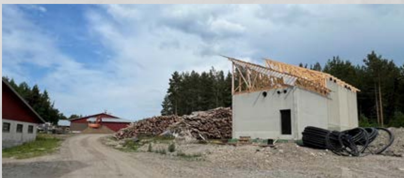
Besök vid en av ÖK:s medlemmar, Andreas Helenelund, tog en ny produktionsinriktning från smågris- till slaktsvinsproduktion. På bilden ny flisvärme-central under uppbyggnad vid Hällboda.
