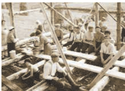
Vielä 1930-luvun alussa Likolahti muistutti enemmän isoa maatilaa kuin lihanjalostuslaitosta. Yläkuvassa navetta ja taustalla toimitusjohtajan asunto. Keskellä ollaan heinäpellolla työnjohtaja Iitun johdolla ja alimmassa on puimalan rakentajia kahvitauolla.
