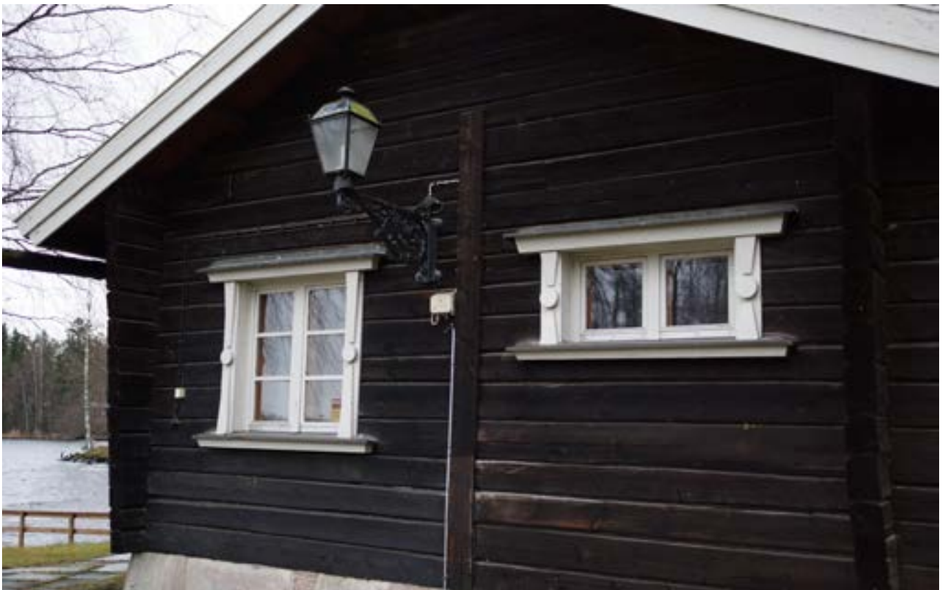
Rantasaunan ikkunoita. Kuva Tengbom Eriksson Arkkitehdit Oy.
