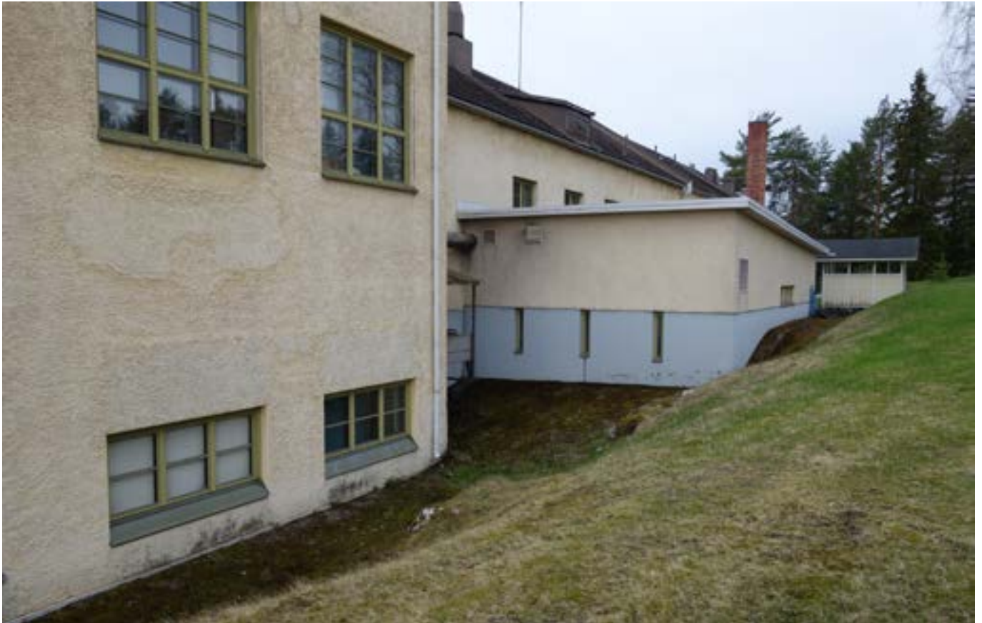
Keittiön laajennus pohjoisjulkisivulla. Kuva Tengbom Eriksson Arkkitehdit Oy.
