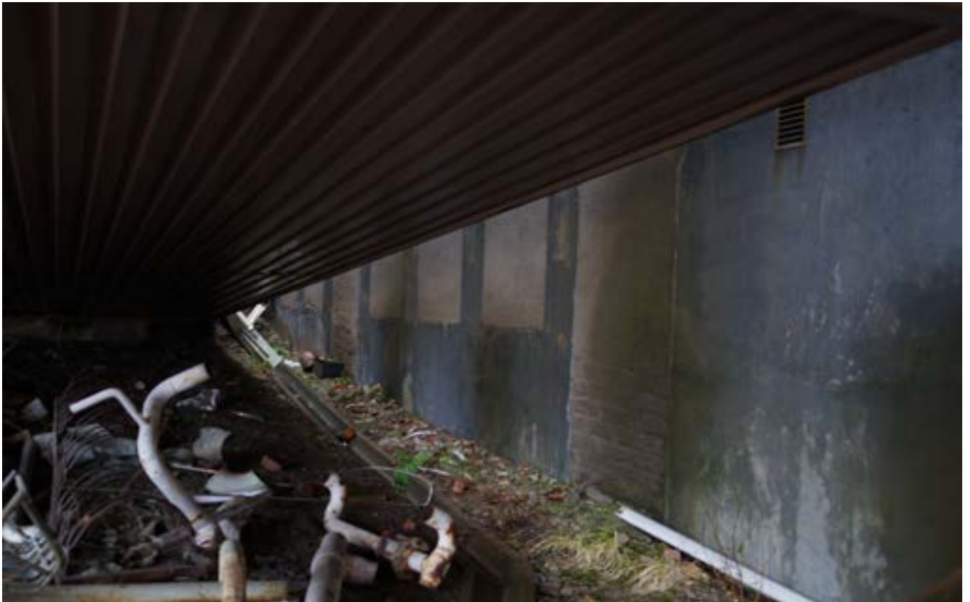
Yhdyskäytävän rakentamisen myötä umpeen muurattu ovi ja ikkunat huoltorakennuksen itäjulkisivulla. Kuva Tengbom Eriksson Arkkitehdit Oy.
