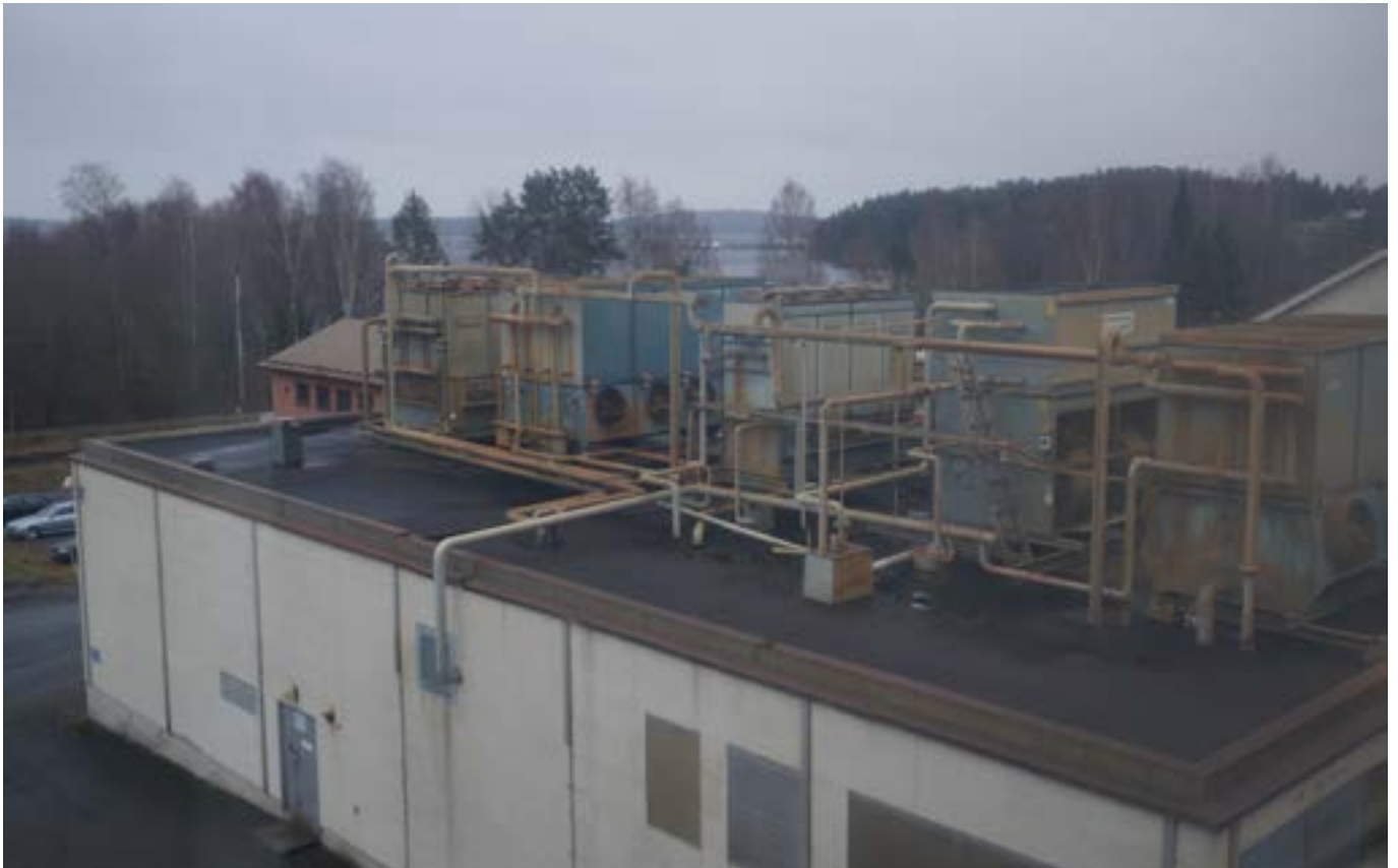
Lämpökeskuksen 1972 ja 1985 tehdyt laajennukset lähettämöstä kuvattuna. Kuva Tengbom Eriksson Arkkitehdit Oy.
