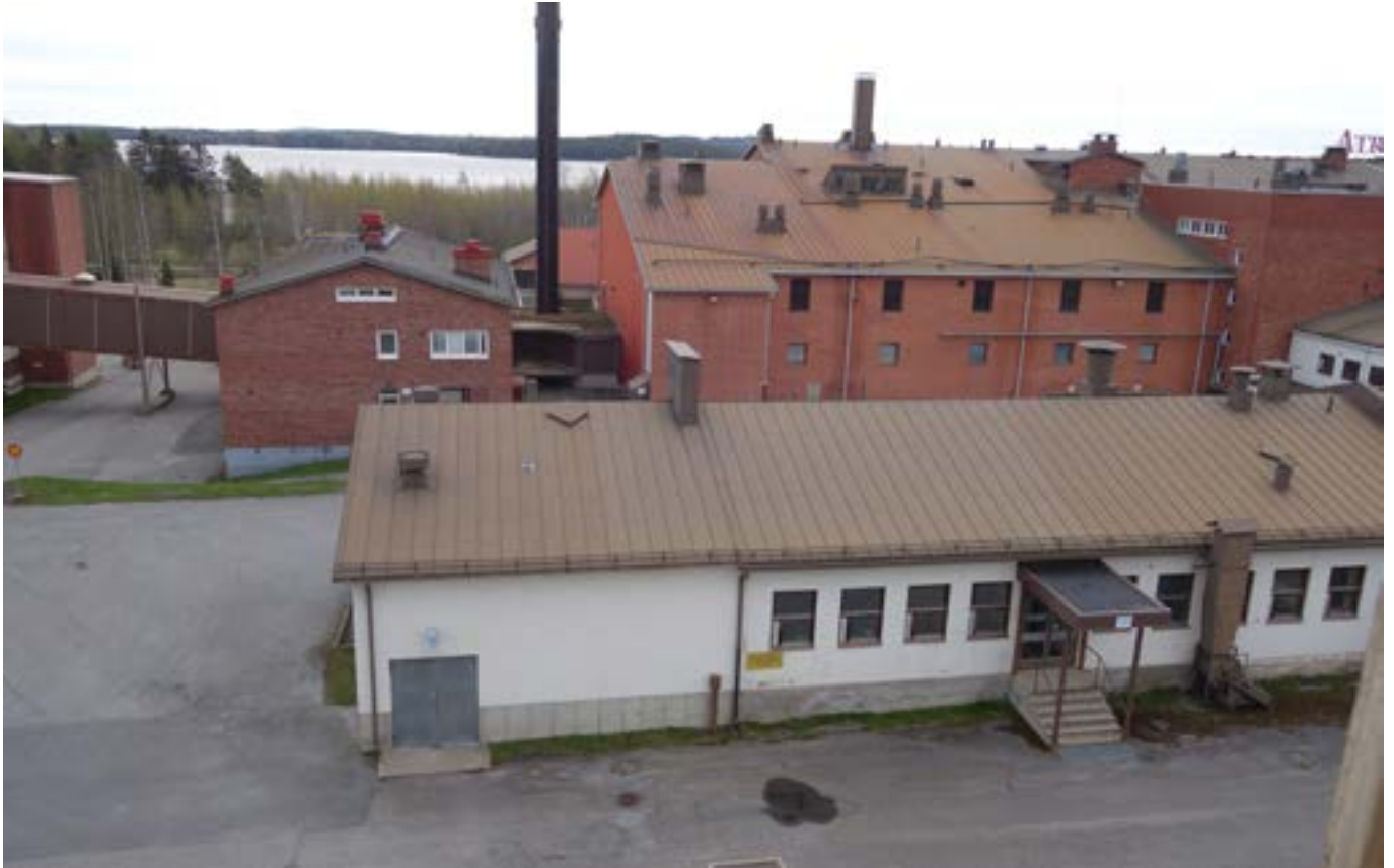
Destruktiolaitos nykytilassaan. Ikkunat ovat kolmiruutuiset. Vasemmalla näkyy vuonna 1980 tehty laajennus. Myös katto on uusittu. Kuva Tengbom Eriksson Arkkitehdit Oy.
