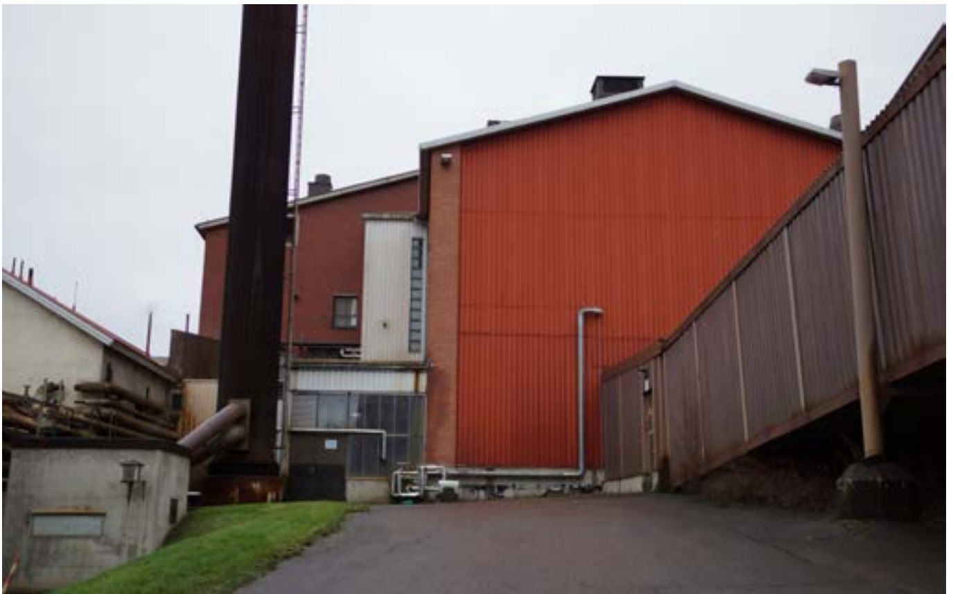
Lihanjalostustehtaan pohjoispäätyä laajennettiin uudestaan vuonna 1984. Oikealla yhdyskäytävä lähettämöön. Kuva Tengbom Eriksson Arkkitehdit Oy.
