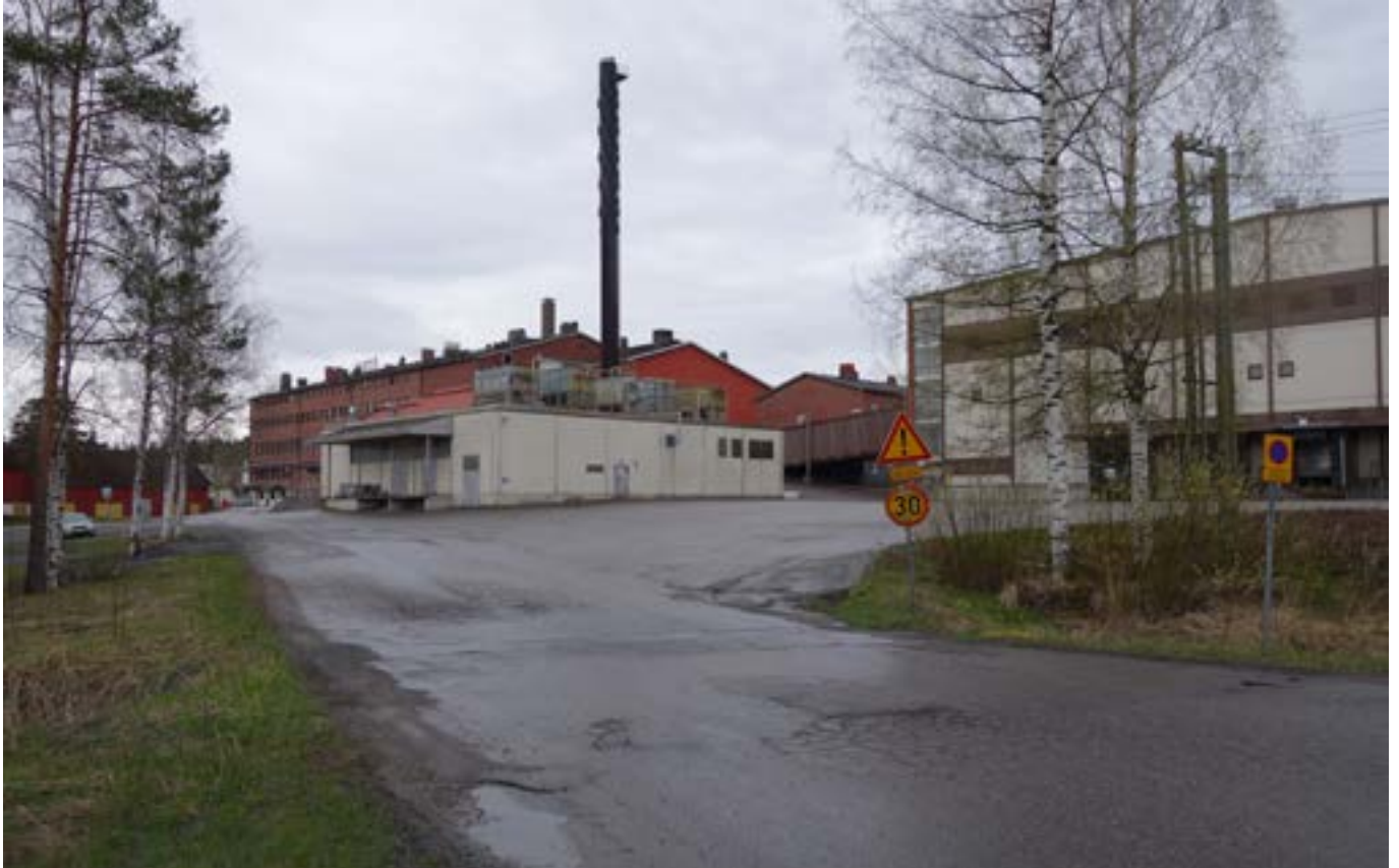
Lämpökeskuksen 1972 ja 1985 tehty laajennus pohjoisen suunnasta. Taustalla lihanjalostustehdas, oikealla lähettämö. Kuva Tengbom Eriksson Arkkitehdit Oy.
