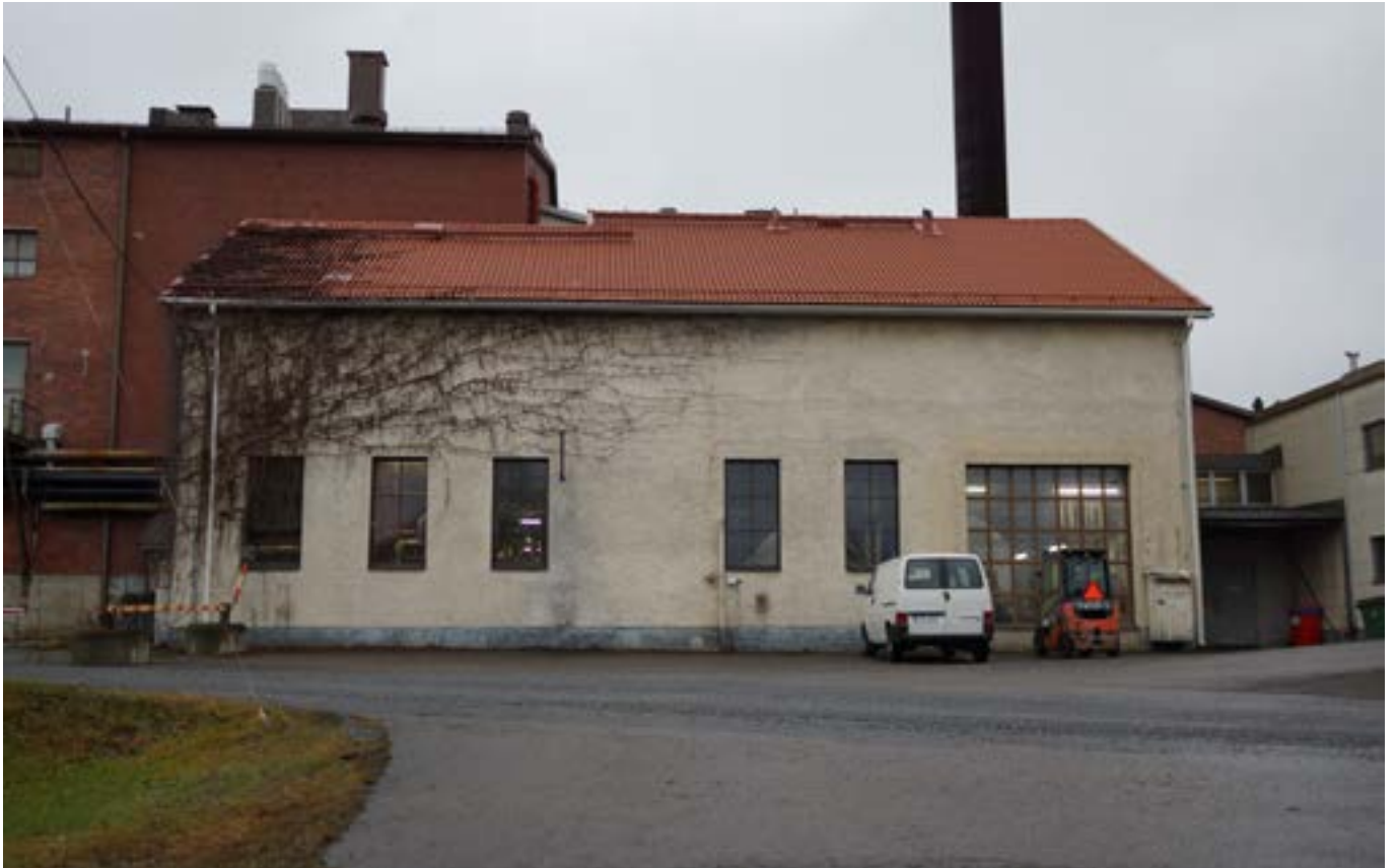
Lämpökeskuksen itäjulkisivun ikkunat muuttuivat vuonna 1984. Kuva Tengbom Eriksson Arkkitehdit Oy.
