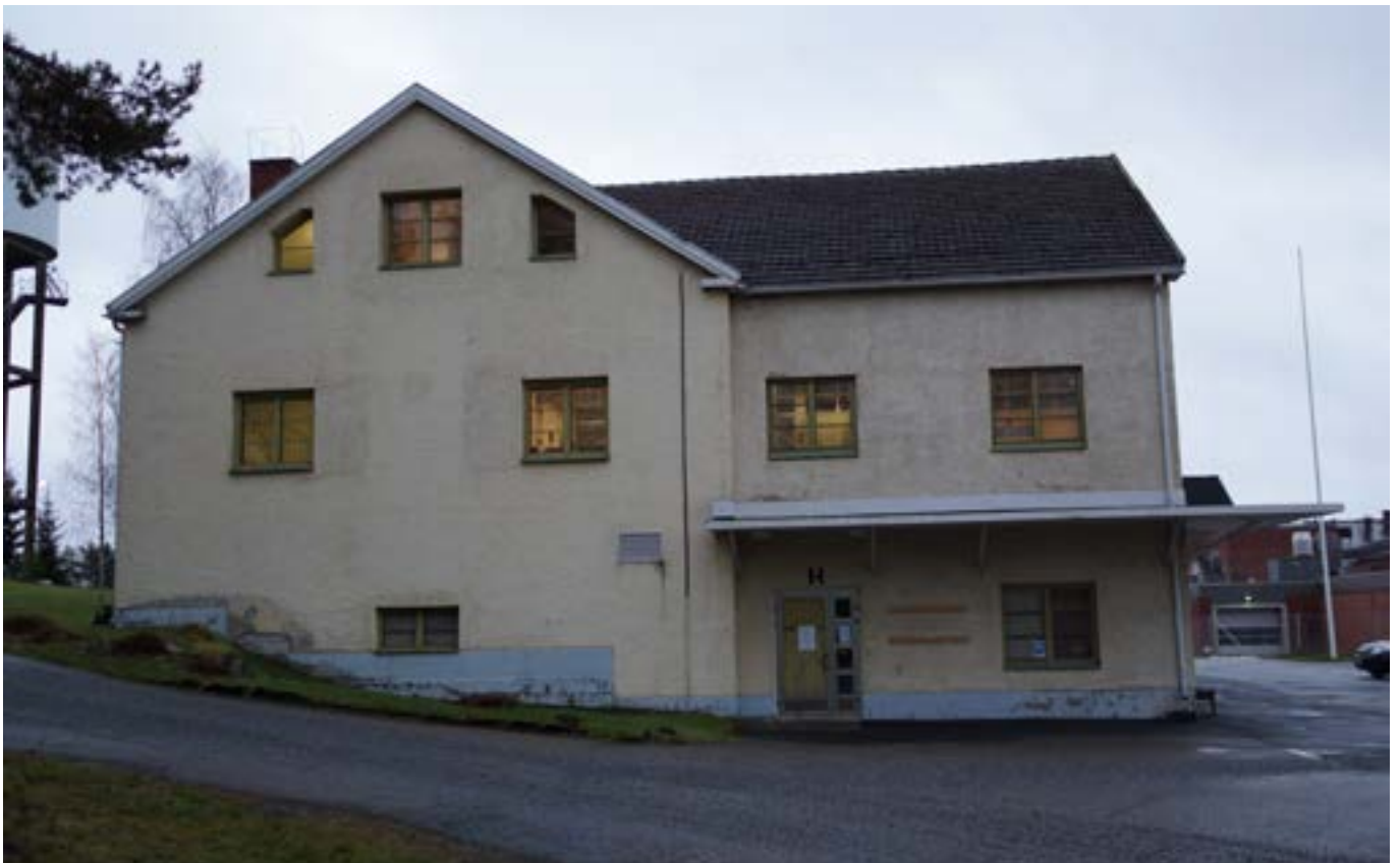
Konttorirakennuksen länsipääty, vuoden 1987 laajennus oikealla. Kuva Tengbom Eriksson Arkkitehdit Oy.
