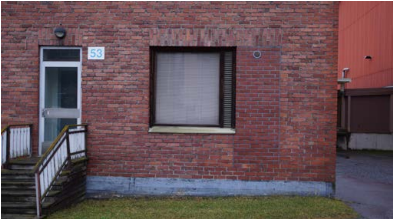
Huoltorakennuksen länsijulkisivulta muurattiin ovi umpeen ja ikkuna uusittiin vuonna 1974. Kuva Tengbom Eriksson Arkkitehdit Oy.
