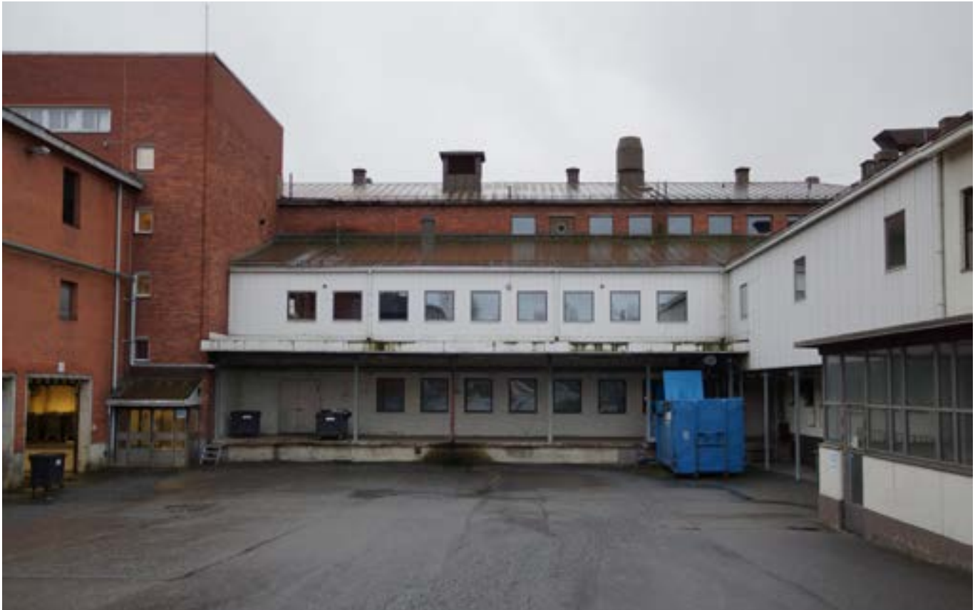
Teurastamon sisäpiha. Vasemmalla lihanjalostuslaitos, keskellä teurastamo, oikealla navetta. Vasemmalla näkyy 1971 laajennettu porraskuili. Porraskuilion alkuperäinen harjakatto muutettiin tasakatoksi. Keskellä ja oikealla ovat 1979 rakennetut valkoiset katseluparvet.
