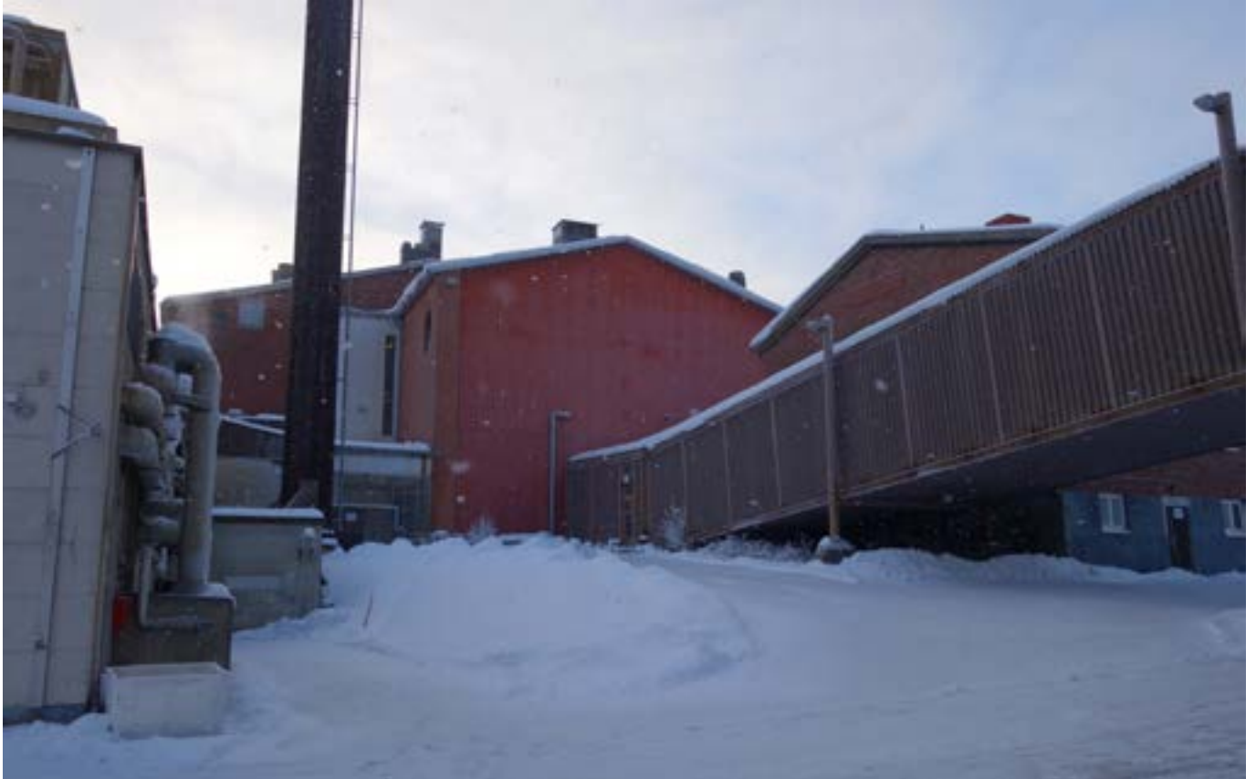
Huoltorakennuksen itäjulkisivun eteen rakennettu yhdyskäytävä lihanjalostustehtaan ja lähettämön välillä. Kuva Tengbom Eriksson Arkkitehdit Oy.
