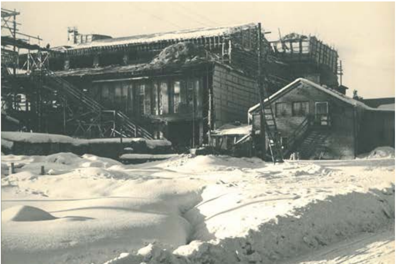
Likolahden teurastamo rakenteilla 1951. Lihakunnan kuva-arkisto.
