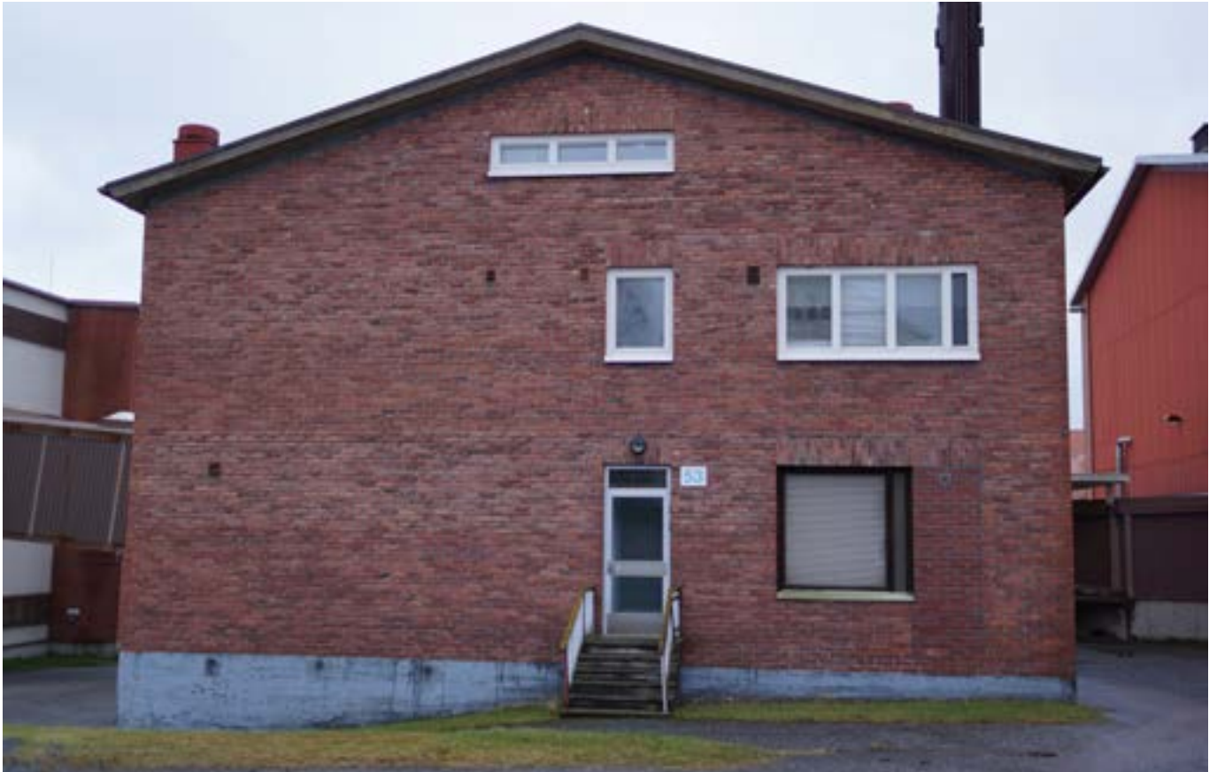
Huoltorakennuksen länsijulkisivu. Vanha myymälän ovi on muurattu umpeen ja ikkuna uusittu. Kuva Tengbom Eriksson Arkkitehdit Oy.
