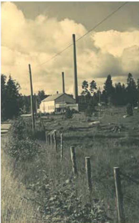
Lämpökeskus 1950-luvun alussa. Lihakunnan kuva-arkisto.
